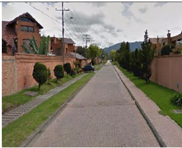
Foto N° 2. Vallado cubierto por lozas de concreto
